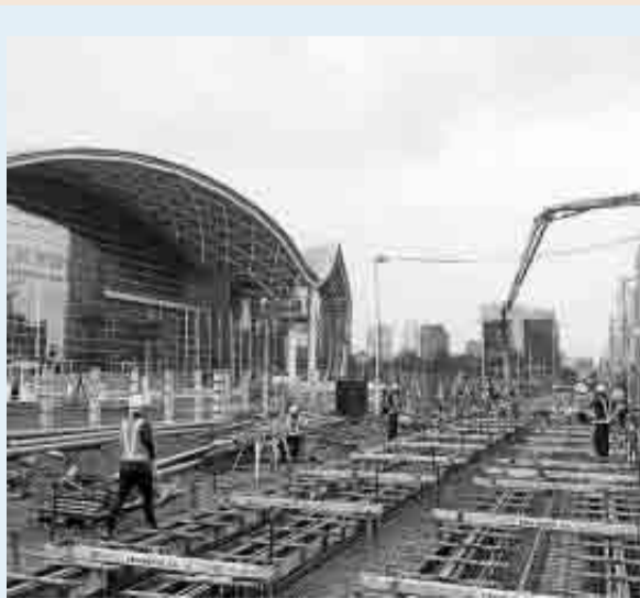
Obras ferroviarias en Taiwán, en las que participa Ecisa.
